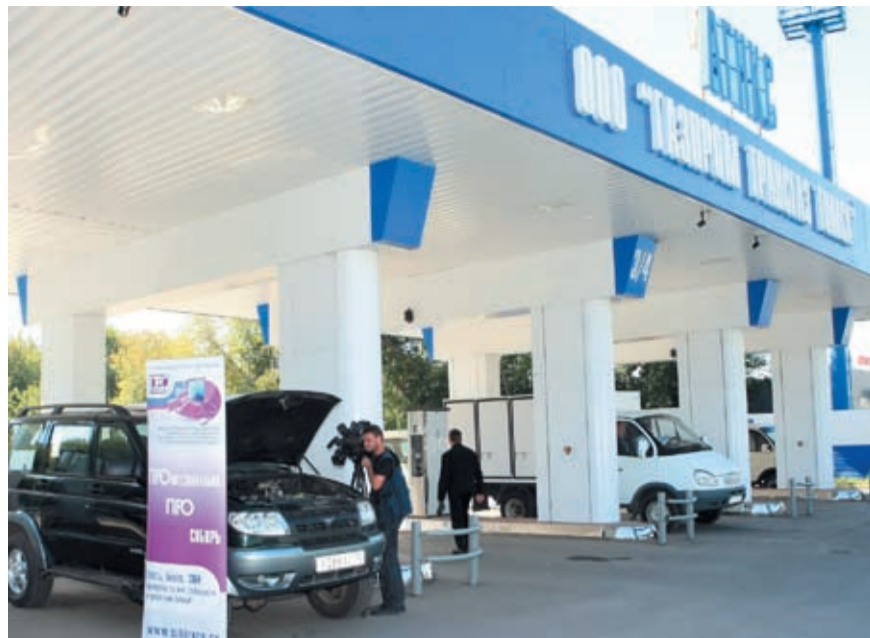
На АГНКС-2 в Новосибирске установлено современное оборудование заправки газом
