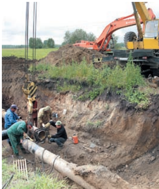
Капитальный ремонт трассы – одна из основных задач новосибирцев
