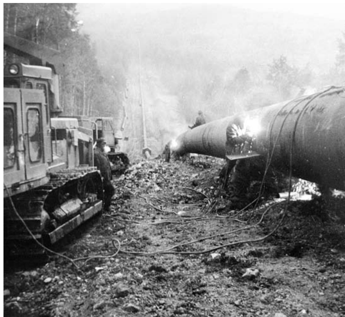
Прокладка газовой магистрали шла строго по плану
